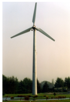
Klärwerk mit Windkraftanlage
